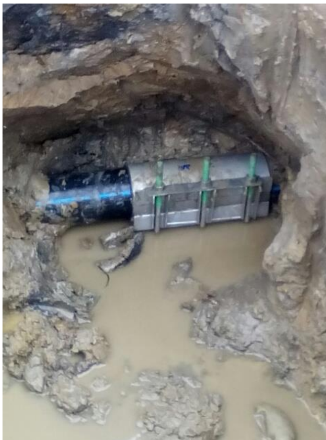
Obr. 4: Porucha na vodovodní přípojce
