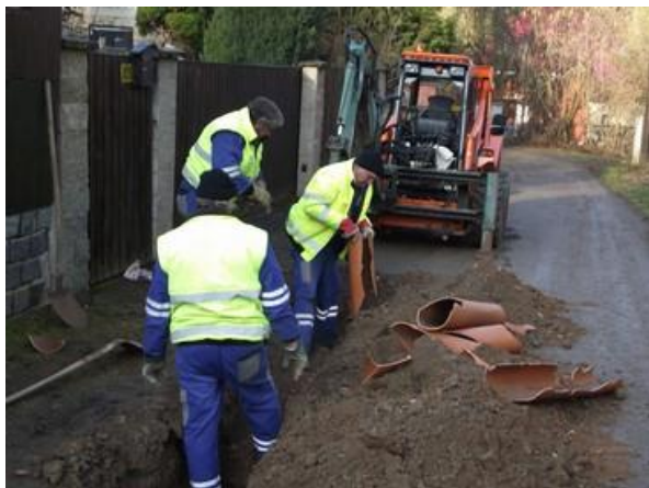
Obr. 20: Odstraňování dešťové kanalizace
