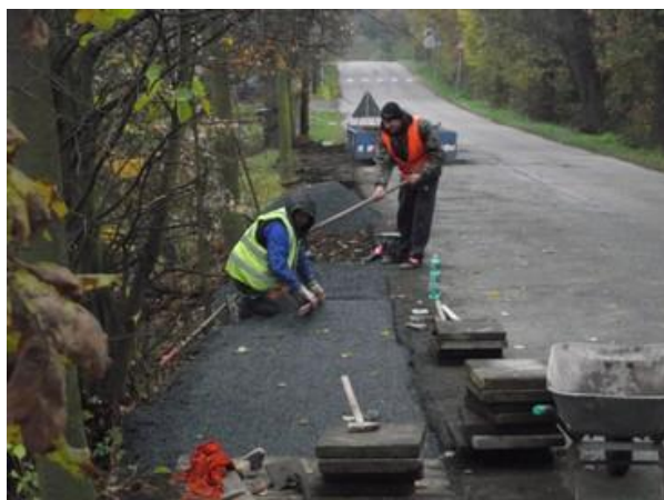
Obr. 14: Rekonstrukce chodníku Pražská
