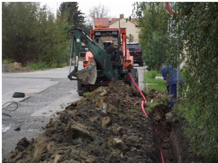
Obr. 17: Výkopy na nové VO
