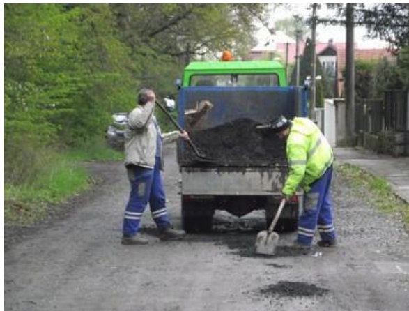
Obr. 12: Oprava výtluků
