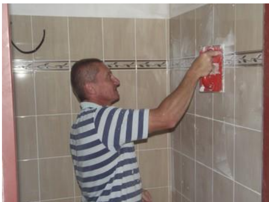
Obr. 7: Oprava sociálních zařízení v MDDM
