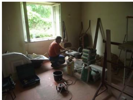
Obr. 8: Rekonstrukce bytu v č. p. 181
